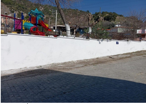
Ortakçı İlköğretim okulun bahçesinde bulunan oyuncak grubu ve Atatürk büstünün bakım, tamir ve boyama işleri yapıldı.
